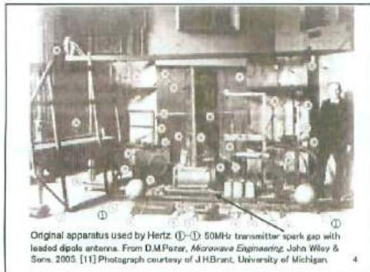
Hertz が 1888 年の実験に使った Hertzian dipole antenna : ①-① と Spark gap : 矢印。動作周波数 : ほぼ 50MHz。
