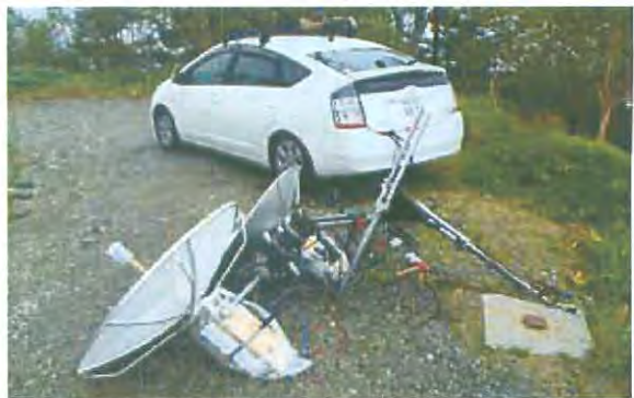
写真5 突風で倒壊した機器 無念！
