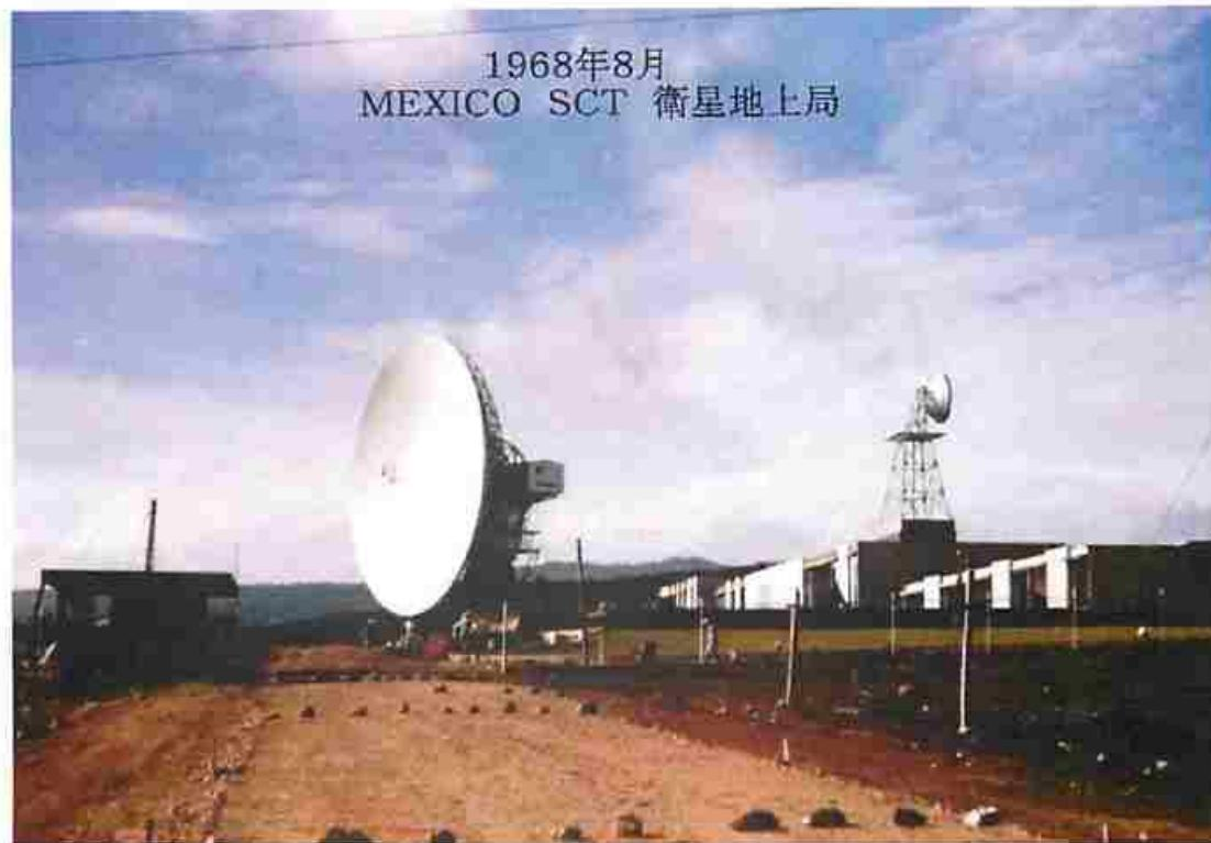
尚、上記の写真で、アンテナ系は、三菱電機さんが納入され、NECは、それ以外の衛星地上局 及び MEXICOシティ迄のアプローチマイクロ回線を納入しました。
