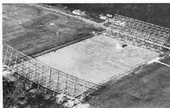
図 9(a). Big Ear: Ohio State University radio astronomy antenna. 右端:長さ 110m の平面レフレクタ、仰角調整し観測領域を走査、左端: 収束用パラボラレフレクタ、両レフレクタ間距離 = 約 160m. 右端レフレクタ前方中央にホーンアンテナ、その下の地下室に Parametric Amplifier が配置されている。
