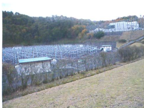
写真1：左 MU レーダーアンテナ、右制御棟 地上波雑音侵入防止のため播鉢構造と金属ネットで周囲を囲っている。
