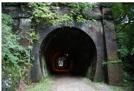
作品3 アプトの道 トンネル
